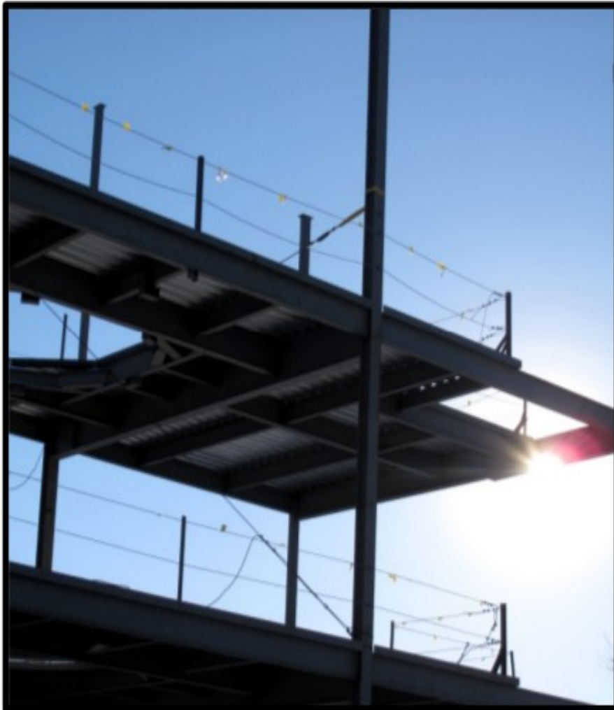
Barandales de acero
